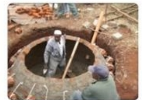
Bau von Biogasanlagen für Haushalte in Kenia
