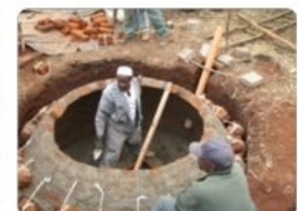
Bau von Biogasanlagen für Haushalte in Kenia
